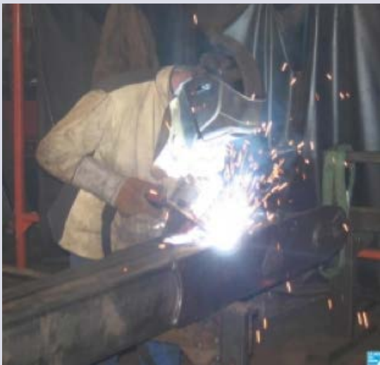
Opération de soudure provoquant des étincelles
